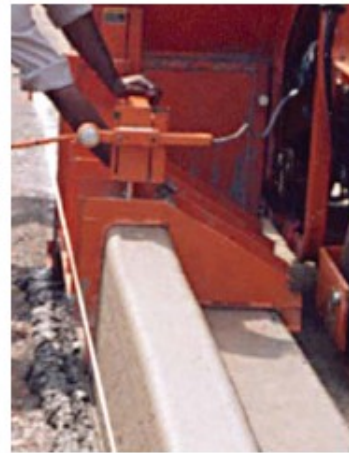
Drop pour mode, pavement to subgrade
